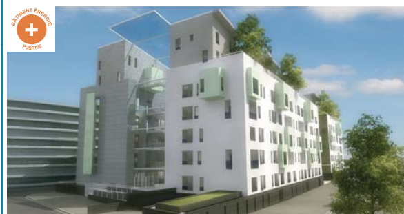
"la Nef" à proximité de la gare TGV - Tours Restructuration de l'ancien centre de tri postal en bâtiment à énergie positive
