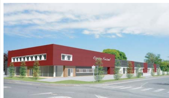
L'Espace Fresnel à Chambray-lès-Tours : un exemple de restructuration d'un bâtiment ancien de 2 500 m 2 sur le site d'activités Les Aubuis - Jean Perrin. Situé à proximité d'un échangeur sur l'A10, ce bâtiment se compose de 8 lots de stockage avec possibilité de surface de bureaux.
